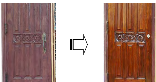
玄関扉（木製）の補修と塗装例
